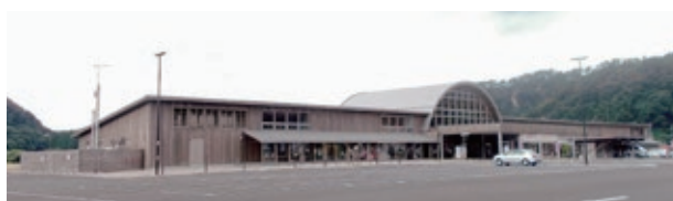
道の駅ふたつ整備事業建設工事 ・給排水衛生設備工事 ・空調和設備工事
