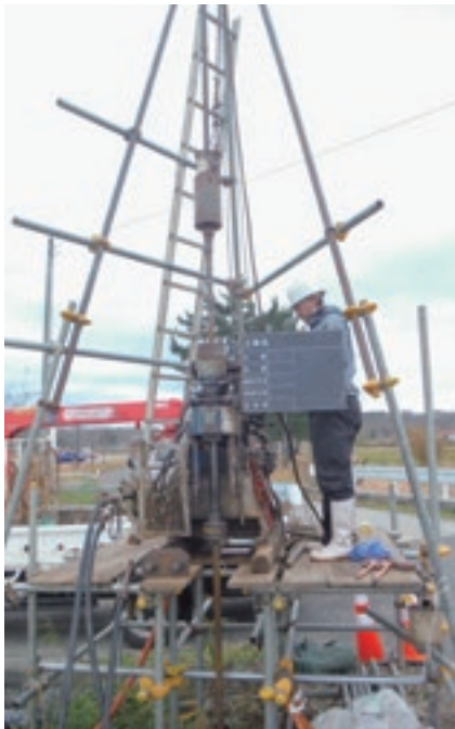
地質調査ボーリング
