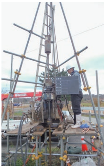
地質調査ボーリング
