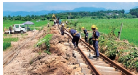
豪雨災害による線路復旧工事
