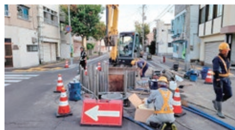
下水道管新設工事
