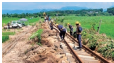
豪雨災害による線路復旧工事
