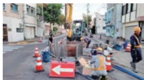
下水道管新設工事
